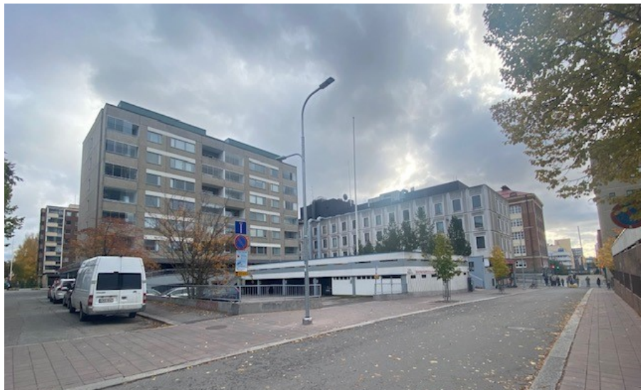
Kuva 6. Näkymä Pinninkadulta. Asemakaavamuutoksessa purettavaksi suunnitellun rakennuksen pihajulkisivua näkyy autokannen takana. Kuva: Sanna Lahti, 2023.
